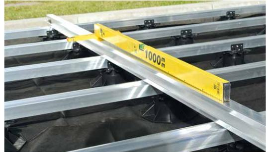
Die Alu- oder Holz-Unterkonstruktionsleisten können auch auf Betonelemente gesetzt werden. Die Ausschiftung wird mit Forex- oder Kork-Plättchen ausgeführt.
