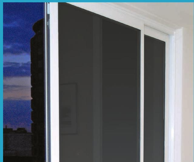
Flache Wandanschlussprofile gestalten den fließenden Übergang vom Mauerwerk zur eigentlichen Schiebewand.
